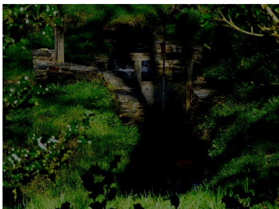
Le bassin de répartition entre le bief et le ruisseau (le Stain)
