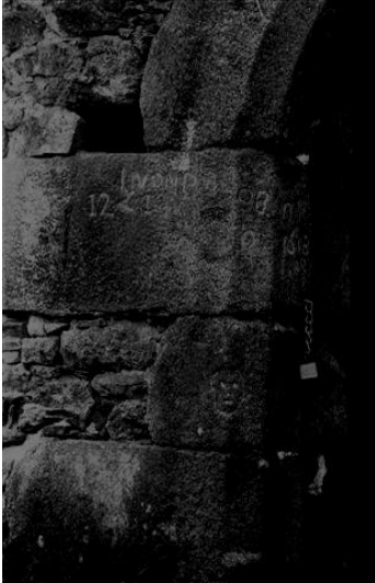
Porte d'entrée du moulin du haut construite à l'aide de pierres de réemploi
