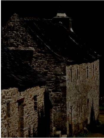
Maisons du village de Kerouat : toitures à coyaux et à pureaux décroissant
